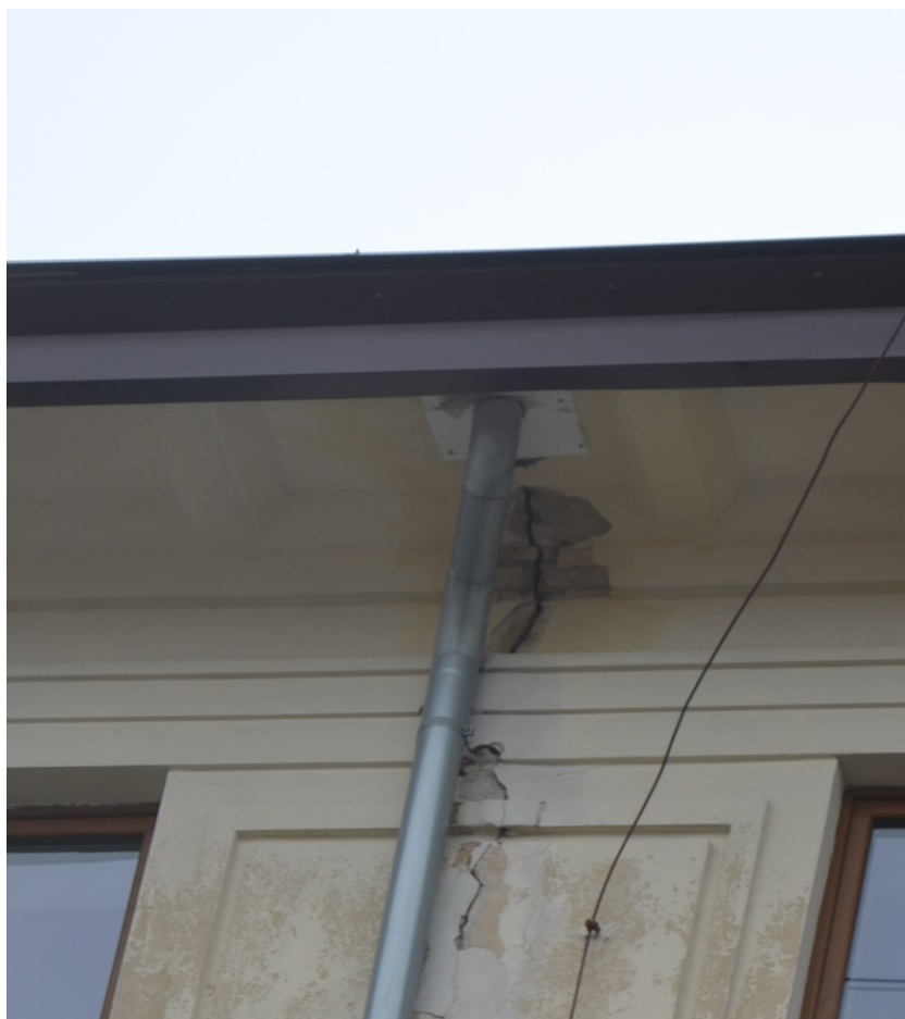
Obr 6 - 7: Příklady prasklin zdiva.
